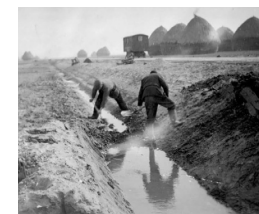
Aanleg polders in drooggelegde Zuiderzee
