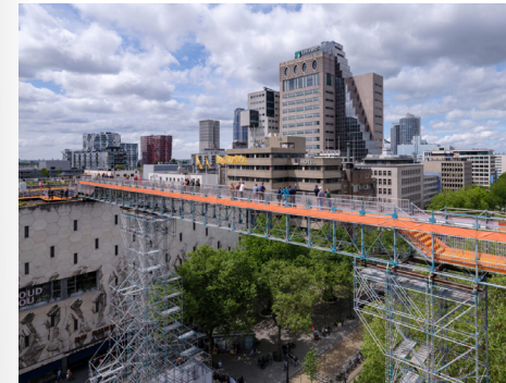
Referentie Dutch Steigers: Dakendagen - Brug over Coolsingel Rotterdam Materialiteit: steigerwerk
