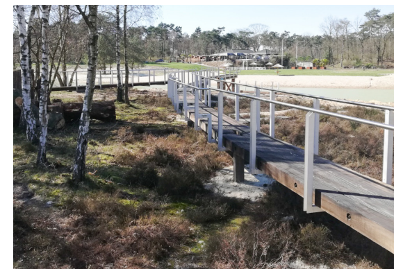
Referentie variant 2: Van Hese Groep - Belevingsbrug de Heide Bergen op Zoom Materialiteit: Gebruikt hardhout, gebruikte draglineschotten, RVS
