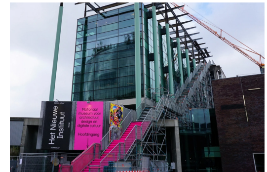
Referentie Dutch Steigers: Architectuur Maand - Trap naar dak Nieuwe Instituut Rotterdam Materialiteit: steigerwerk
