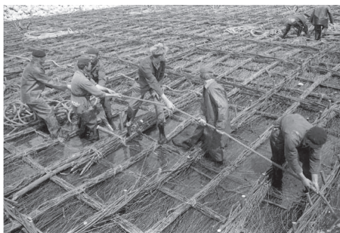
Het vlechten van matten voor het maken van zinkstukken.
