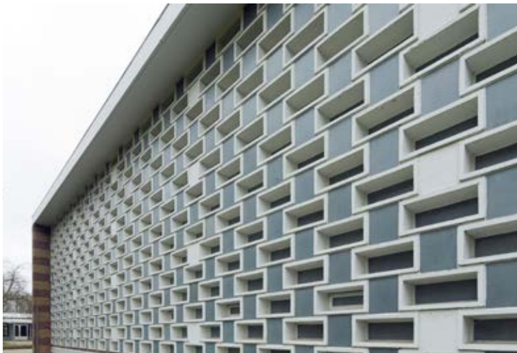
De claustrawand van de voormalig rooms-katholieke kerk bestaat uit opengewerkt beton en glas.
