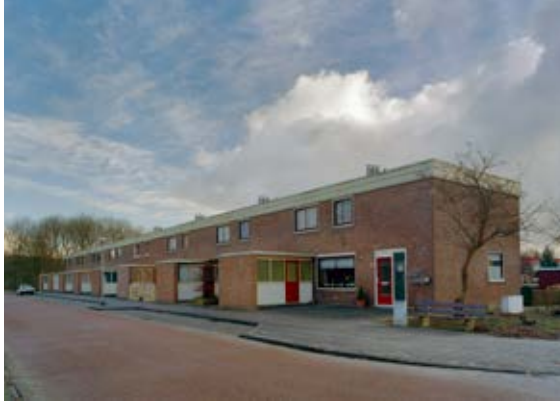
De notabelenwoningen aan de Ring hebben bergingen aan de voorkant, wat in de jaren vijftig van de vorige eeuw nog ongebruikelijk was.
