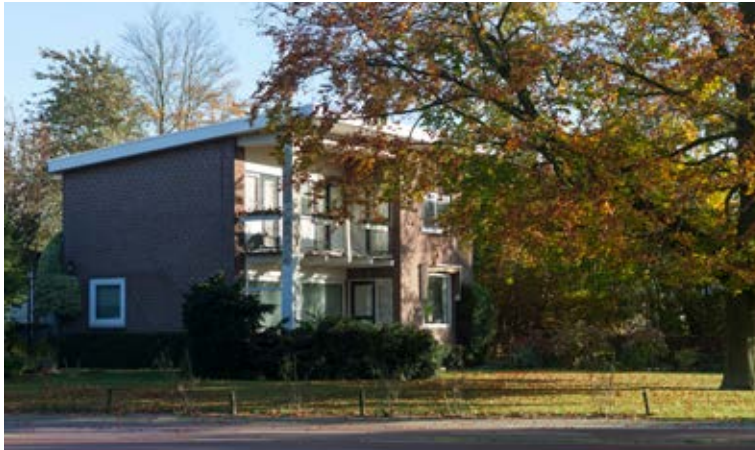
Decennialang markeerde deze villa aan de Ploegstraat het begin van Nagele. In tegenstelling tot alle andere gebouwen in Nagele heeft het huis een flauw hellend dak.
